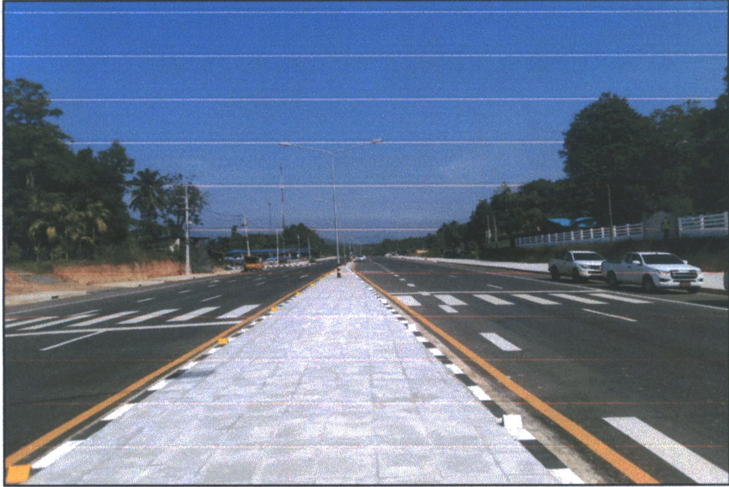
ภาพที่ ๓ ภาพถ่ายตอนก่อสร้างแล้วเสร็จ
