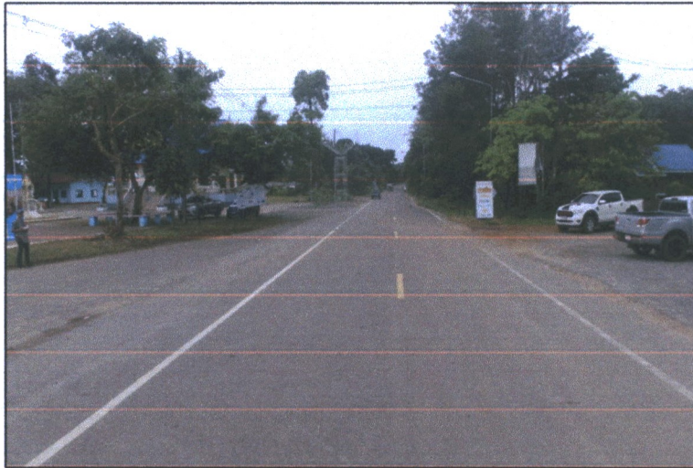
ภาพที่ ๒ ภาพถ่ายสภาพก่อนการปรับปรุงถนน
