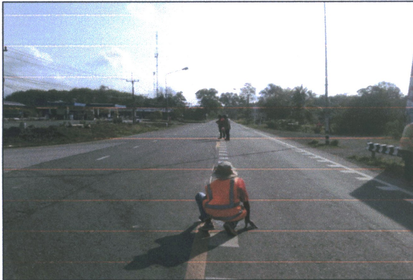
ภาพที่ ๒ ภาพถ่ายก่อนการดำเนินการก่อสร้างปรับปรุง
