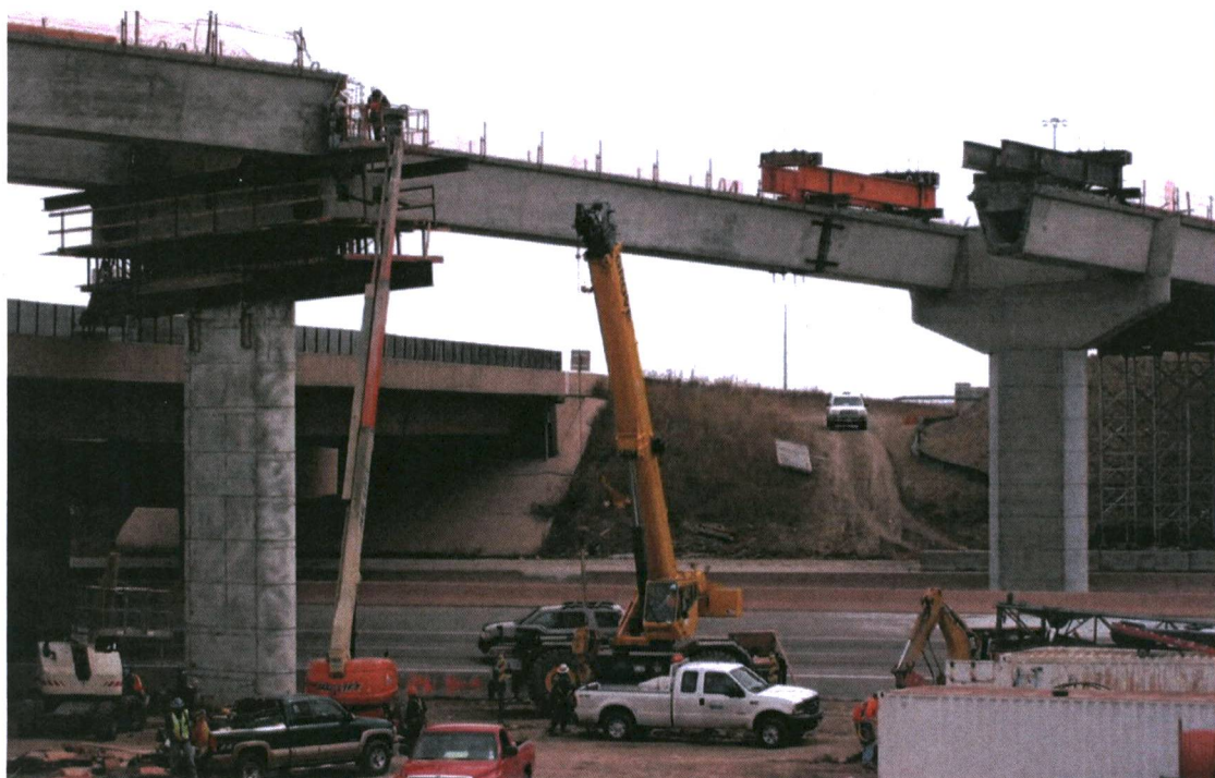
รูปที่ ๑๐ แสดง SPLICED U BEAM
