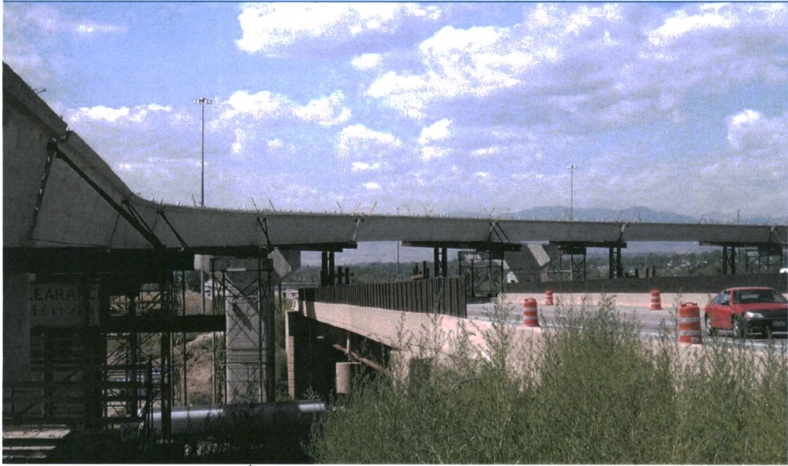
รูปที่ ๑๑ แสดง SPICED U BEAM คร่อมถนน
