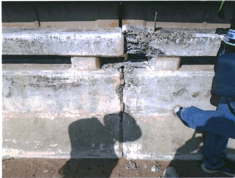
รูปที่ ๒ ปลายราวสะพานทั้ง ๒ ด้าน เกิดการเคลื่อนตัวดันกัน
