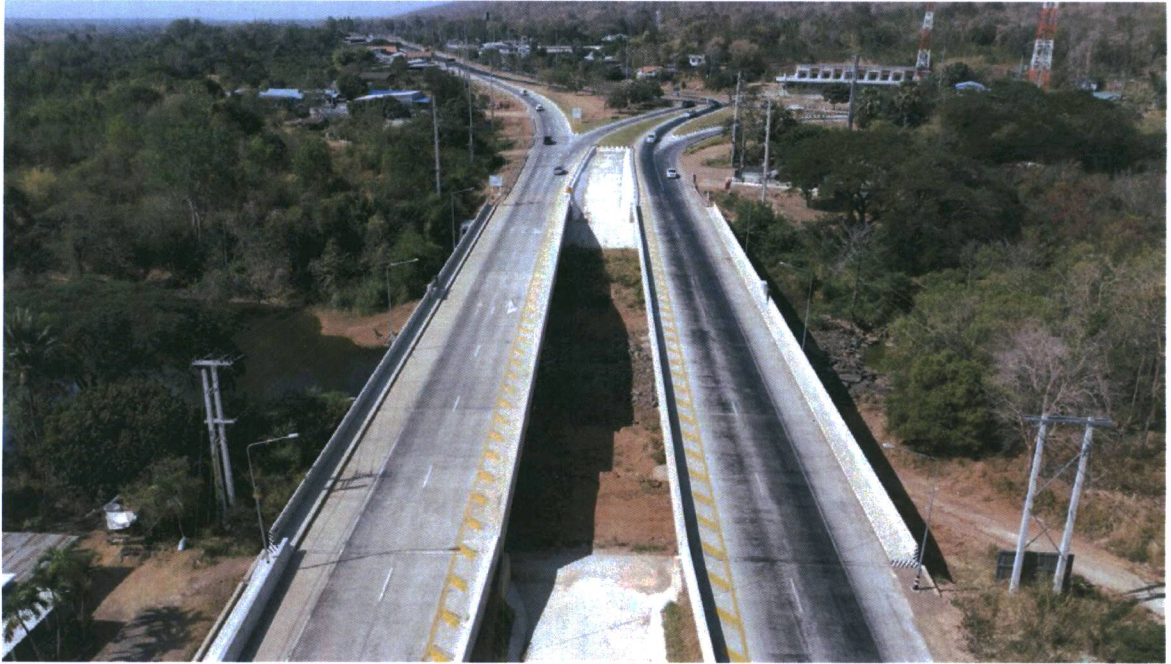
รูปที่ ๑ รูปสะพานข้ามห้วยสามหมอ กม.๕๔+๓๘๗.๐๐๐ ที่ก่อสร้างแล้วเสร็จ
