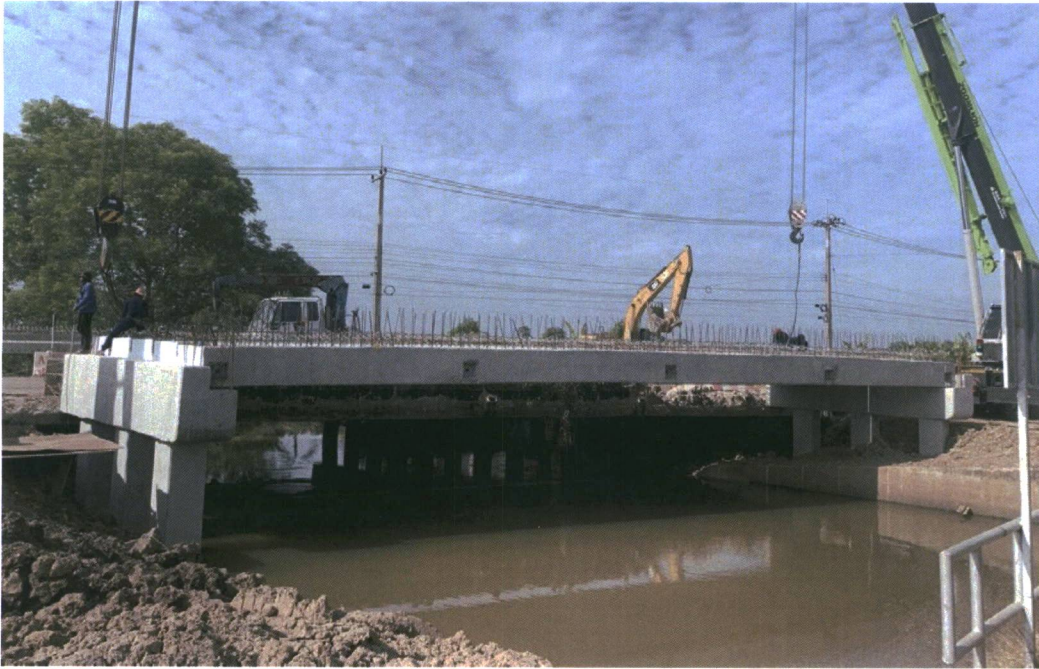
รูปที่ ๒ รูปสะพานข้ามคลองบางเขียด กม.๒๘+๕๐๗.๒๗๔ ที่กำลังก่อสร้าง
