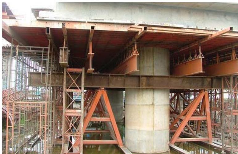
รูปที่ ข.6 การติดตั้งคานรองรับ และตงรับท้องแบบพื้นสะพาน
