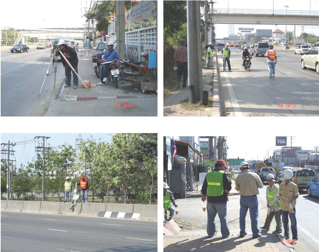
รูปที่ 2.4 การเก็บค่าระดับเพื่อจัดทำรูปตัดสภาพคันทางเดิม (Existing Cross Section)
