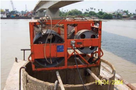
รูปที่ ๑.๘ การตรวจสอบสภาพผนังหลุมเจาะ (Drilling Monitor) โดยใช้เครื่องมือ KODEN
