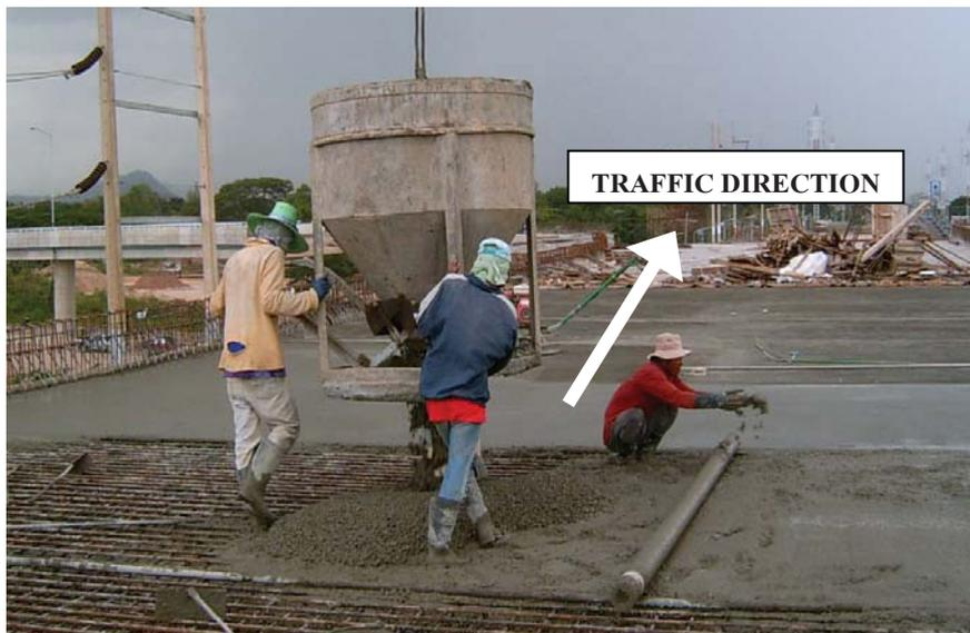
รูปที่ ข.1 แสดงตำแหน่งการวางตัววัดและทิศทางการไสริด พร้อมทั้งเหล็กกระดပ်ในการเทพื้นคอนกรีตสะพาน
