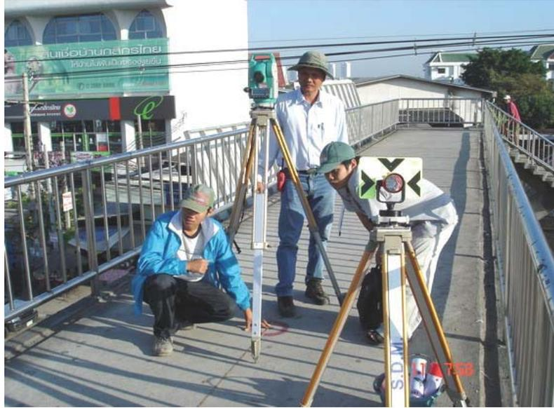
รูปที่ 2.1 การทำจุดอ้างอิงสำหรับการสำรวจและวางแนวด้วยระบบพิกัด
