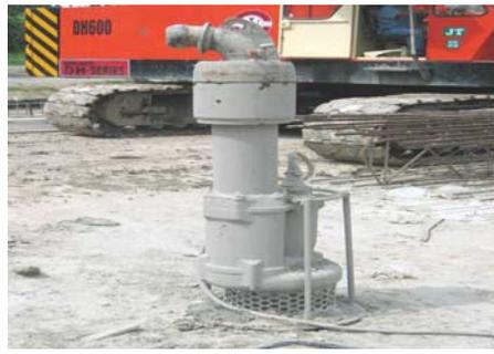
รูปที่ 5.4 เครื่องสูบของเหลวพยางเสถียรภาพออกจากหลุมเจาะขนาดเส้นผ่านศูนย์กลางท่อ 8"
