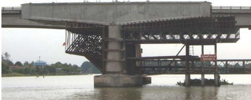
รูปที่ ข.13 แบบหล่อสะพานยื่นที่ใช้แบบเหล็ก
