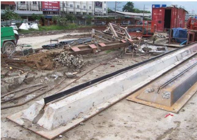
รูปที่ 5.9 แบบหล่อปิดปลายผนังพืด (Stop End Plates) รูปที่ 5.10 ท่อสำหรับเทคอนกรีต (Tremie Pipe)
