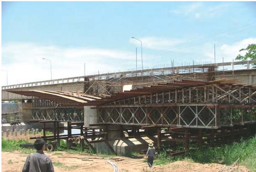
รูปที่ ข.14 แบบหล่อสะพานยื่นที่ใช้แบบไม้
