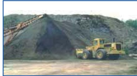
รูปที่ 10.4 การรื้อหรือตัดชั้นทางแอสฟัลต์คอนกรีตเดิม และการย่อยแล้วนำไป Stock Pile
