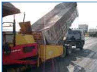
รูปที่ 26 รถขนส่งส่วนผสมแอสฟัลต์คอนกรีต
