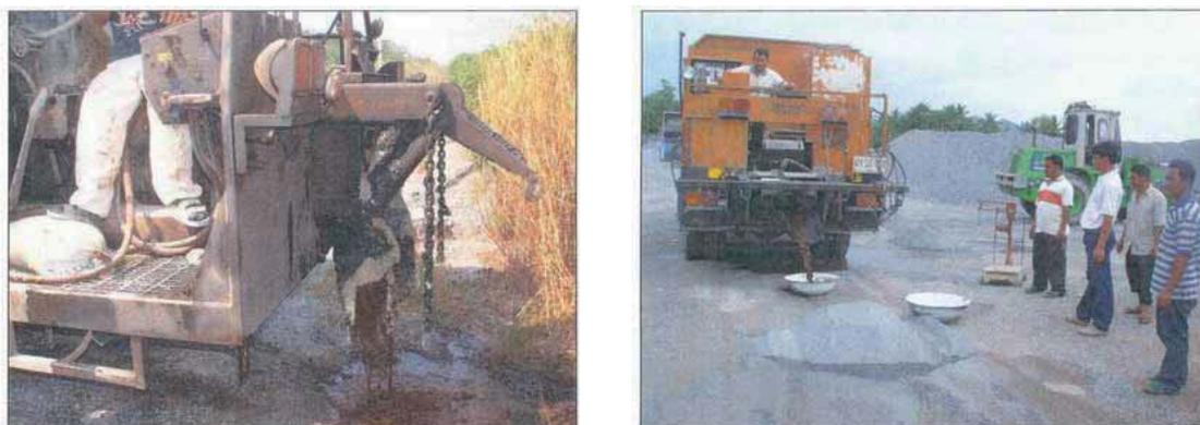
รูปที่ 1 เครื่องจักรงาน Slurry Seal ขณะปรับเทียบเอสฟัลด์
