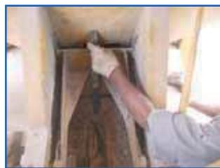
รูปที่ 20 การกำหนดจุดบนสายพานและการกำหนดความสูงปากชั่ง Cold Bin
