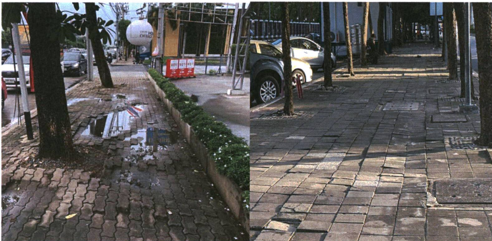
รูปที่ ๓ ปัญหาที่เกิดจากการปูอิฐบล็อกทางเดินเท้าได้ไม่ดี (อ้างอิงจากเพจเฮ้ยนี้มันฟุตบอลไทยแลนด์ และเพจทางเท้าเมืองไทยจัดการใหม่ได้หรือยัง)
