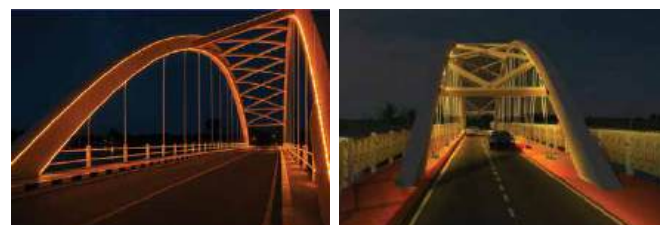
ภาพตัวอย่างของสะพานหลังการบูรณะและติดตั้งระบบไฟส่องสว่าง
