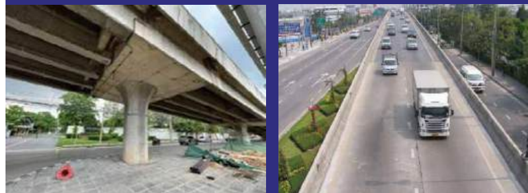
ภาพรวมของสะพานตัวอย่างและสภาพการจราจรของรถบรรทุก
