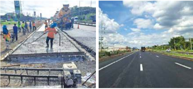
ทางหลวงหมายเลข 2 ตอน บ่อทอง - มอจะบก กม.92+000 LT. - กม.93+840 LT.
