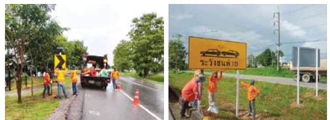
ทางหลวงหมายเลข 1 ตอน 1401 พาน - ร่องขุน กม.890+370 - กม.919+034
