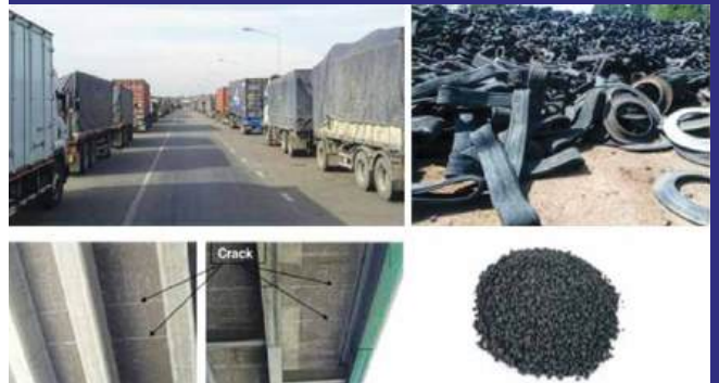
สภาพปัญหาพื้นสะพานแตกร้าเนื่องจากความล้าจากการจราจรของรถบรรทุกหนักและเศษยางรถยนต์เก่าบดละเอียด
