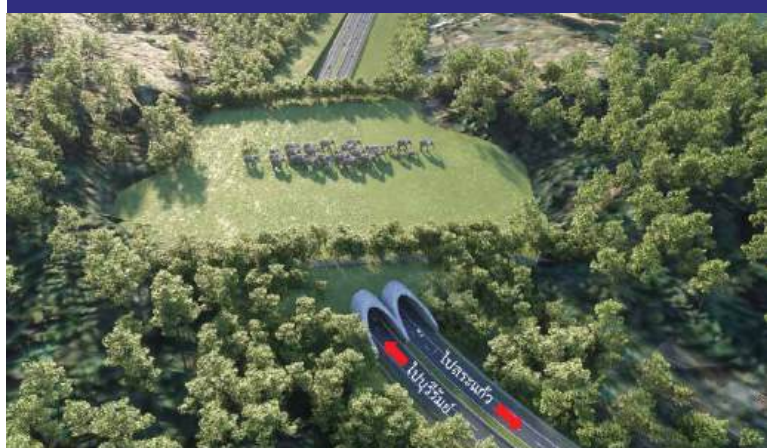
ภาพเสมือนจริงบริเวณที่ออกแบบเป็นอุโมงค์แบบดินตัดและถมกลับ ช่วงกม.79+925 ถึง กม.80+225
