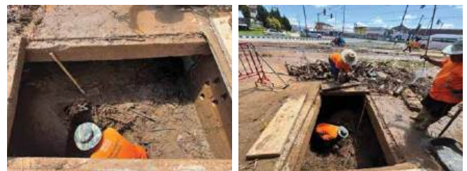
ทางหลวงหมายเลข 1149 ตอน 0100 ห้วยไคร้ - ห้วยน้ำริน กม.0+030 - กม.0+050
