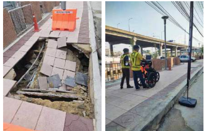
บริเวณที่มีการยุบตัวของทางเท้าและการสำรวจด้วยเครื่อง GPR
