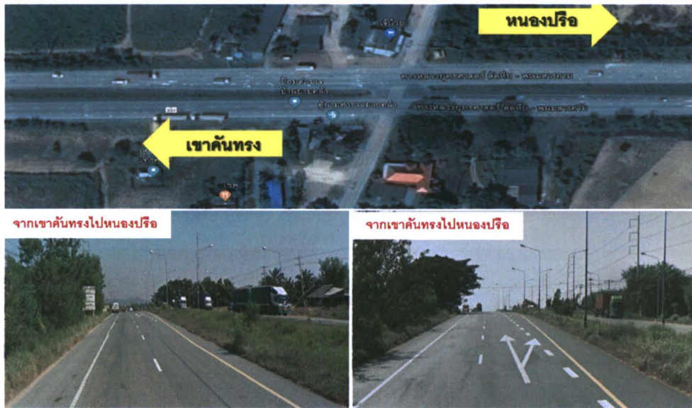
รูปที่ ๔ แสดงภาพถ่ายทางอากาศและสภาพถนนเดิมก่อนมีโครงการฯบริเวณทางเข้าวัดมาบค้ำ
