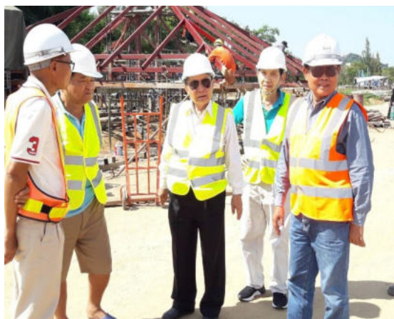
นายช่างเอกวิชัยและทีมงาน ขณะกำลังควบคุมงานก่อสร้างโครงการรถไฟรางคู่ ช่วงหัวหิน - ประจวบคีรีขันธ์
