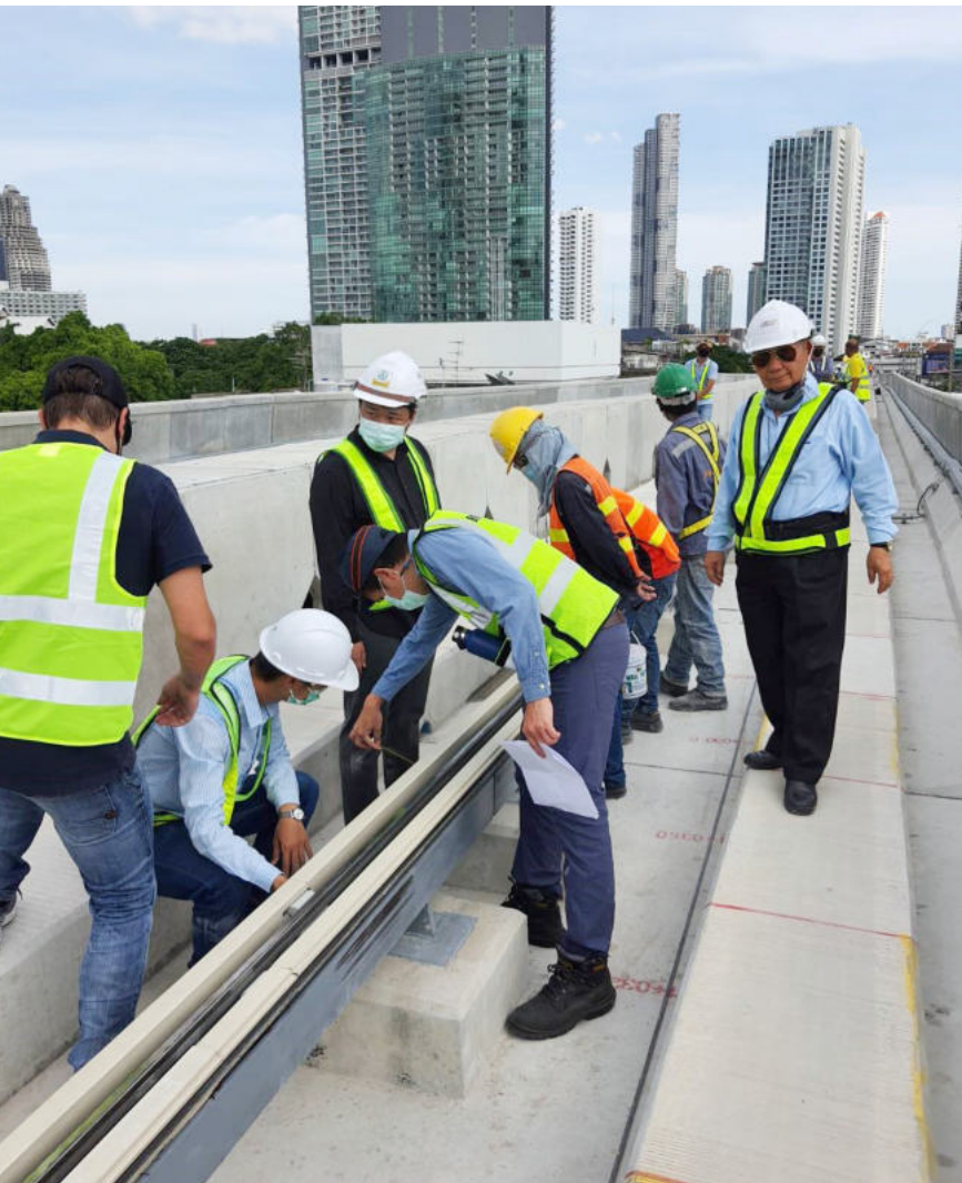
ควบคุมงานก่อสร้างโครงการรถไฟฟ้า สายสีทอง
