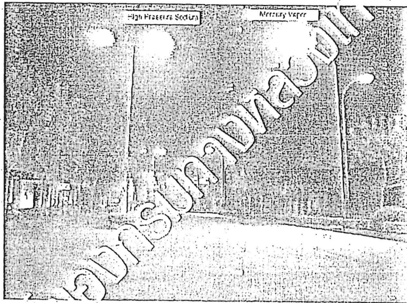
รูปที่ ข-5 เปรียบเทียบไฟส่องสว่างทางหลวง แบบโซเดียมความดันไอสูงและแบบปรอทความดันไอสูง
