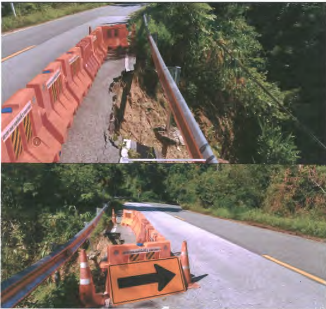
รูปที่ ๓ รูปสภาพหน้างานที่เกิดกับพิบัติ ช่วง กม.๖๔+๐๒๕ - กม.๖๔+๕๐๐
