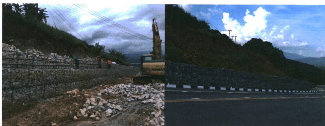
รูปที่ ๒ การก่อสร้างกำแพงป้องกันดินสไลด์ (Gabion Wall)
