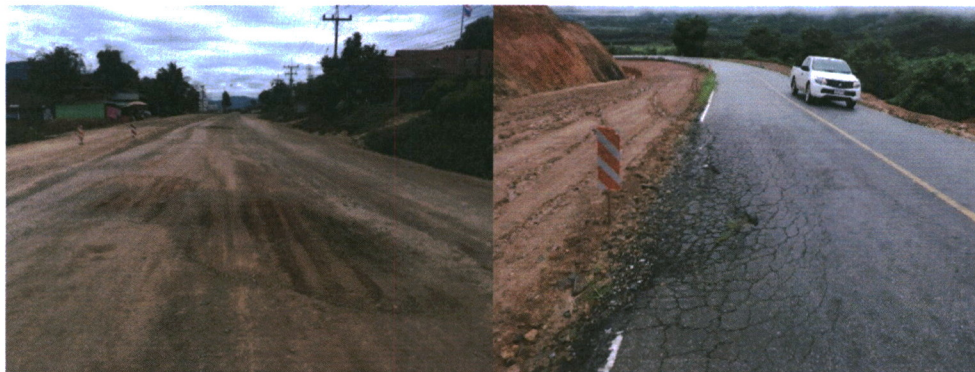
รูปที่ ๑ ความเสียหายของถนนเดิม
